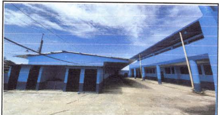
Foto 4: MÓDULO 1 AULAS MANTENIMIENTO A ESTRUCTURA DE METAL
