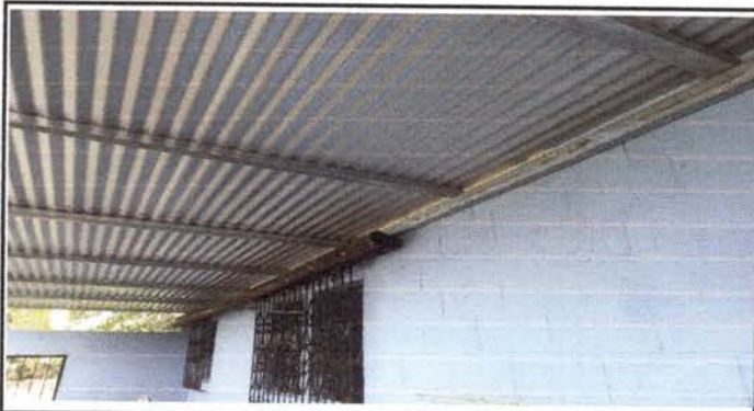
Foto3: MÓDULO 1 AULAS SUSTITUCIÓN DE LÁMINA, POR LÁMINA TROQUELADA ALUZINC CALIBRE 26
